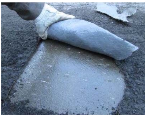
写真－2. 1 防水層の損傷事例
